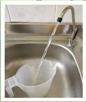
Impianto acqua microfiltrata
